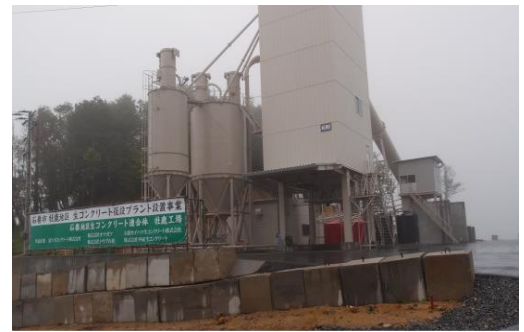
谷川小跡地に建設された生コン工場
