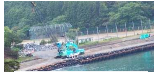
護岸工事が進む荻浜中学校
