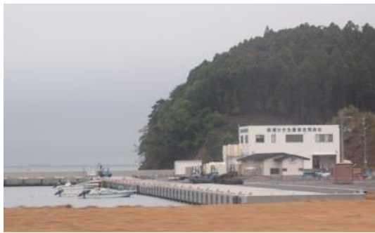
漁業の株式会社化工事が進む桃浦浜
